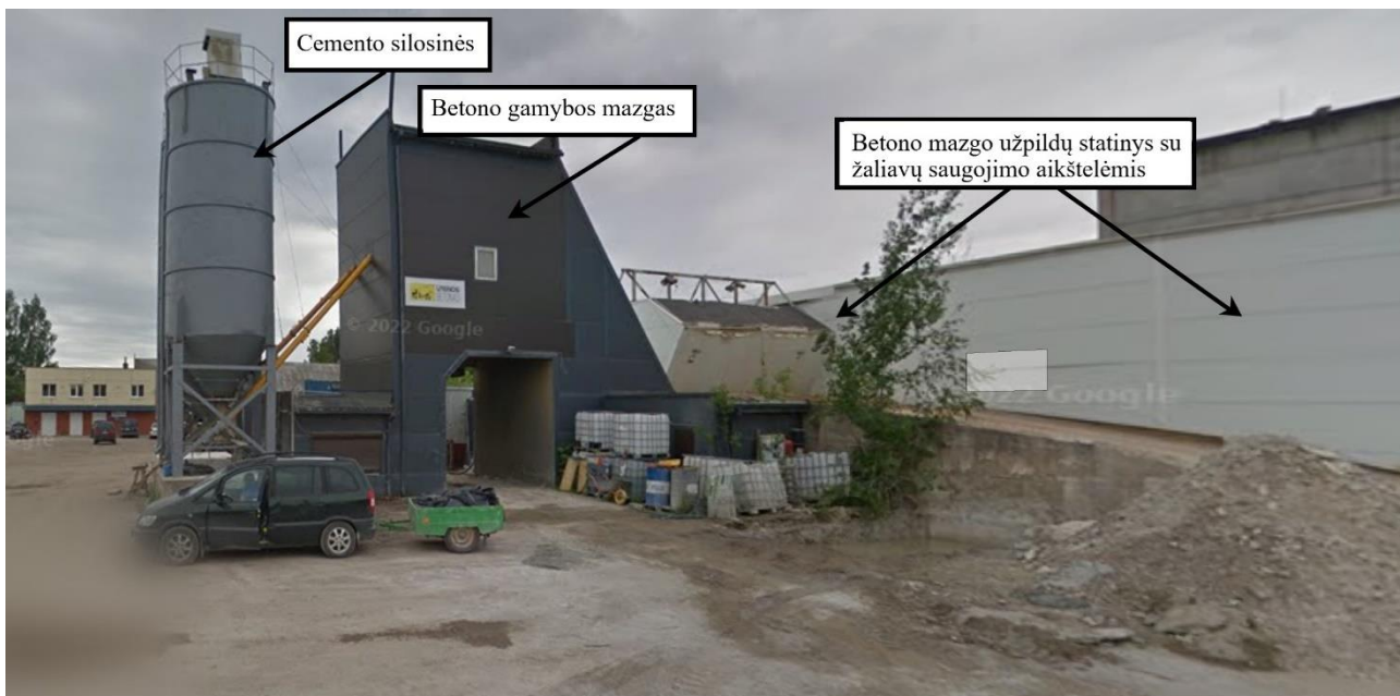
1 pav. UAB “Utenos betonas” gamybos mazgas su žaliavų sandėliavimo statiniais.
